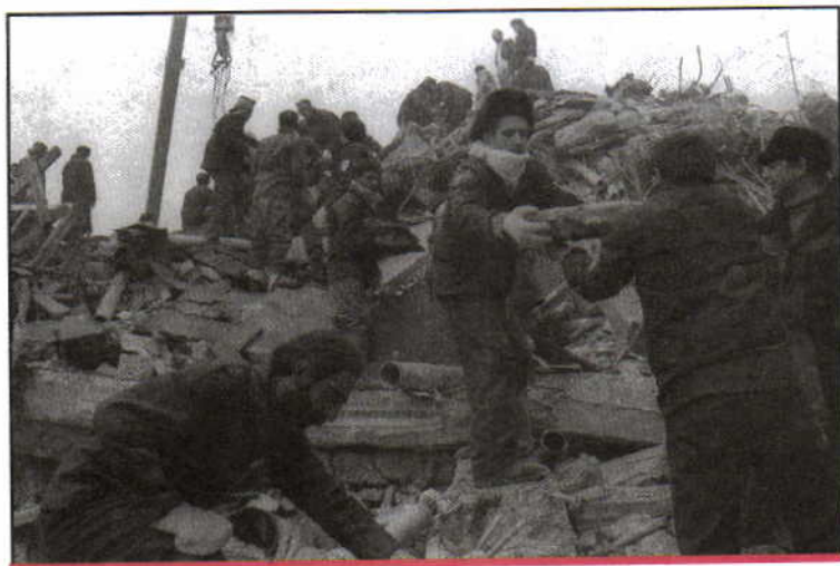
Землетрясение в Армении привело к огромным человеческим жертвам и разрушениям. Декабрь 1988 г.
