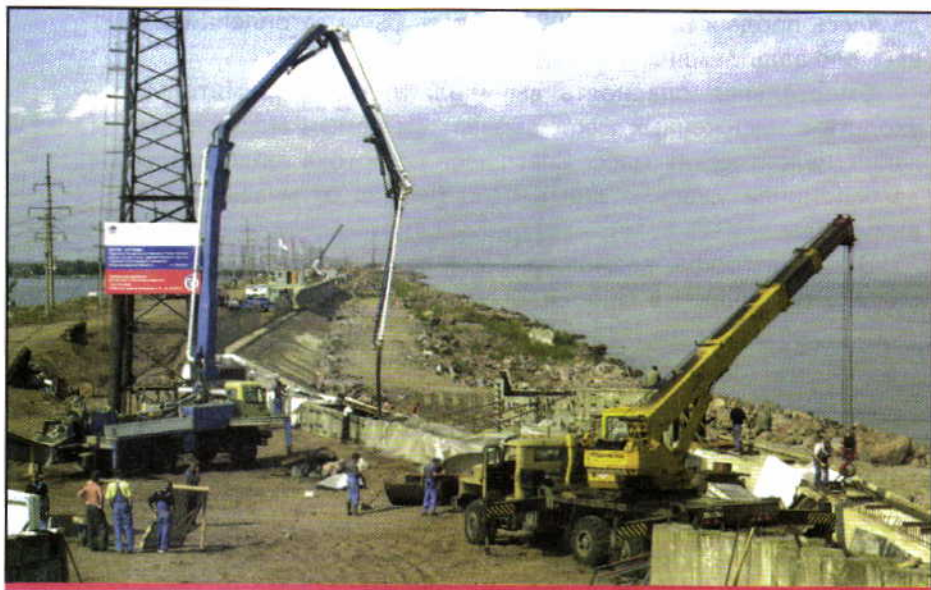
На строительной площадке комплекса защитных сооружений по защите от наводнений (Санкт-Петербург). 2003 г.
