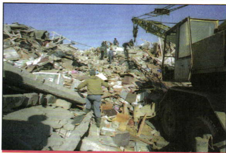
Спасатели разбирают завалы от обрушившихся зданий после землетрясения в Нефтегорске
